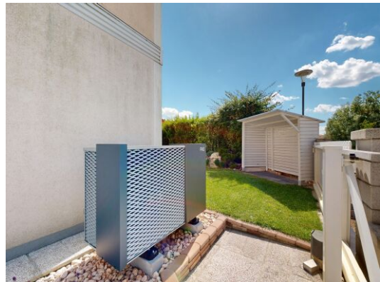
Außengerät Luftwärmepumpe
