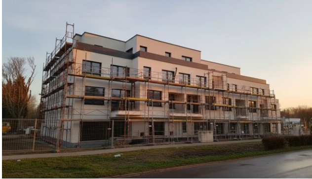
Aktueller Baufortschritt Q1 2026
