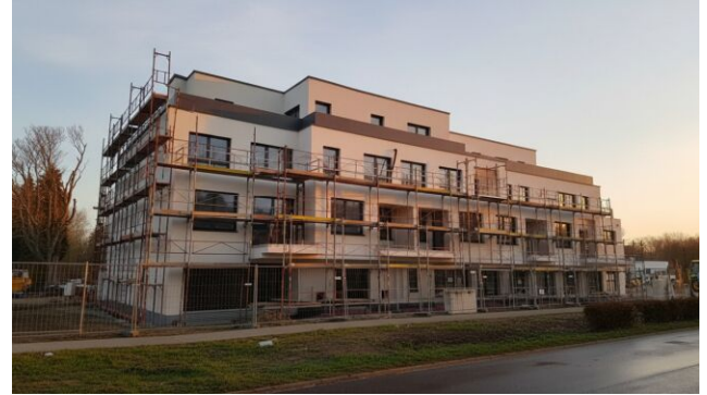
Aktueller Baufortschritt Q1 2026
