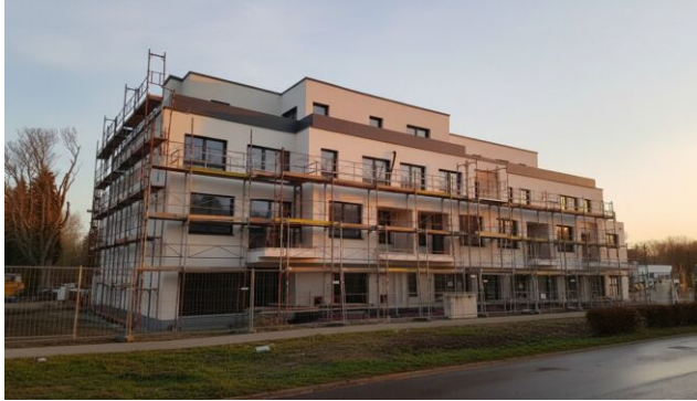
Aktueller Baufortschritt Q1 2026
