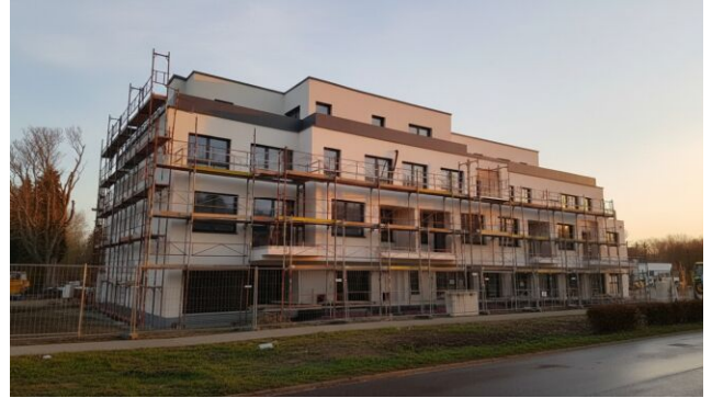
Aktueller Baufortschritt Q1 2026
