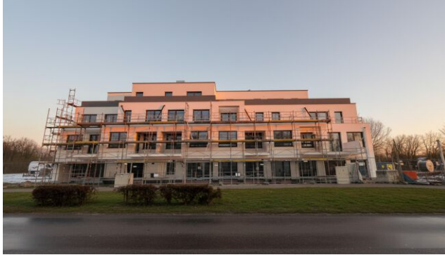
Aktueller Baufortschritt Q1 2026
